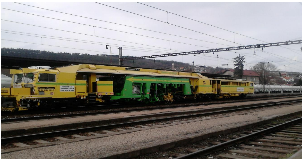
Obrázek č. 7: Úprava železničního svršku
