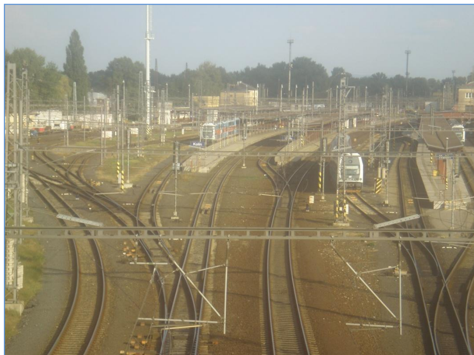
Obrázek č. 1: Železniční infrastruktura
