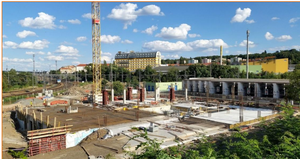
Obrázek č. 18: Výstavba budovy CDP Praha
